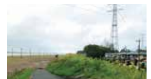
田中調節池 住宅地沿い周囲堤
