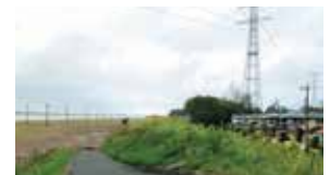
田中調節池 住宅地沿い周囲堤
